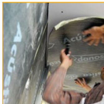
Grampo em primeira placa (teto flutuante)
