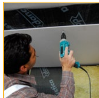
Coloque a segunda placa (teto flutuante)
