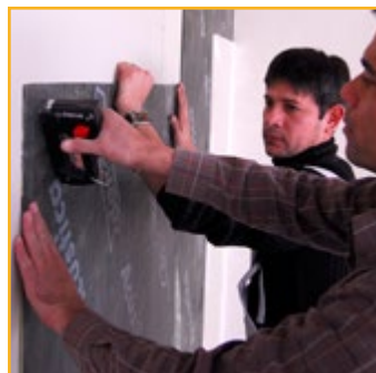
Grampo em primeira placa (parede)
