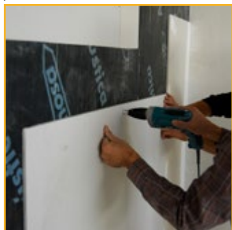
Coloque a segunda placa (parede)
